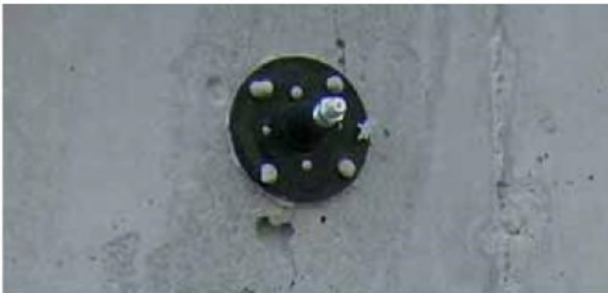
Figuur1: de opbouwnippel aanbrengen in het midden van de scheuropening.
